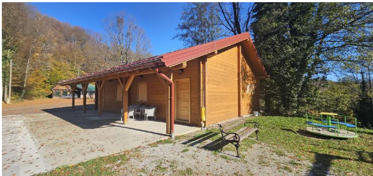
Slika 67. Društveni dom Gladovec Kravarski na području naselja Gladovec Kravarski. Izvor: Level Project d.o.o.
