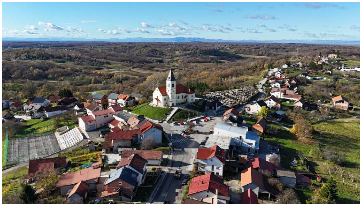
Slika 55. Crkva Uzvišenja Svetog Križa u naselju Kravarsko. Izvor: Level Project d.o.o.
