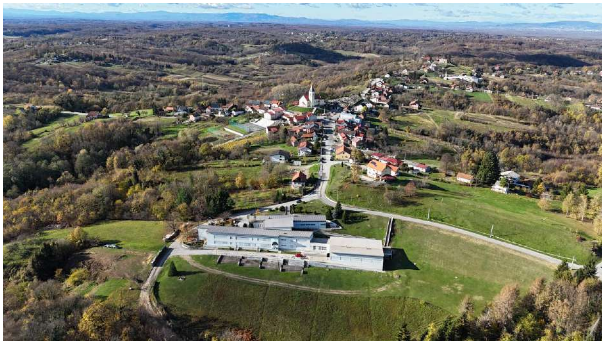
Slika 1. Općina Kravarsko. Izvor: Level Project d.o.o.
