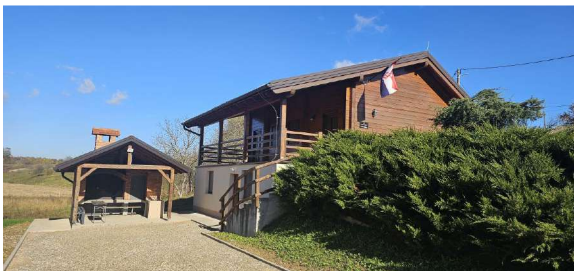
Slika 57. Društveni dom Barbarići Kravarski. Izvor: Level Project d.o.o.
